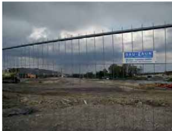
Schleusenneubau in Bolzum 2008
